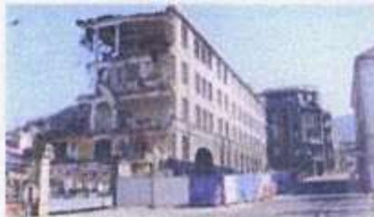
Der Abriss ist in vollem Gange. Bis zum Fensterstein hinaus der Dachstuhl ist geräumt.
