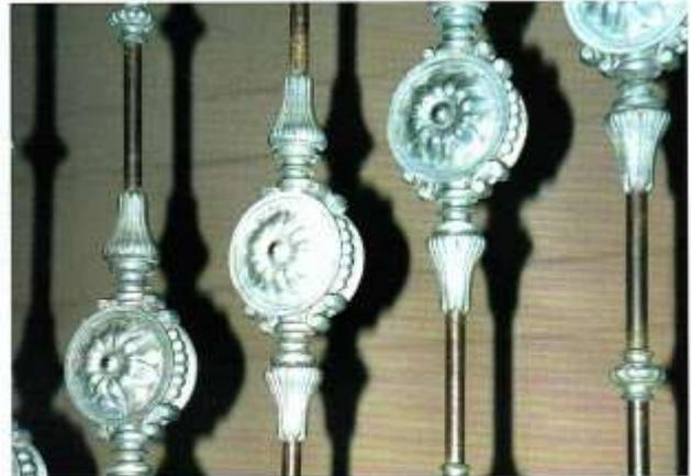
Details am Treppengeländer aus Gusseisen. Charakteristisch ist, dass die Balustraden im Treppenhaus aus Gusseisen ausgeführt wurden. Folglich ist es sehr wahrscheinlich, dass ihre Herkunft sowie die Fenstergitter und die Arbeiten des Eingangstores aus der Pauckschen Gießerei stammen.
