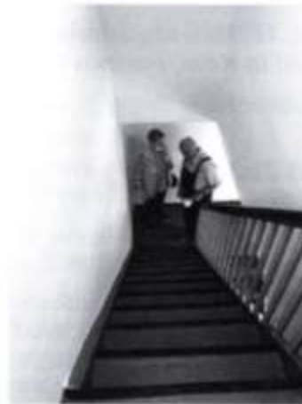
Treppe zum Dachboden
