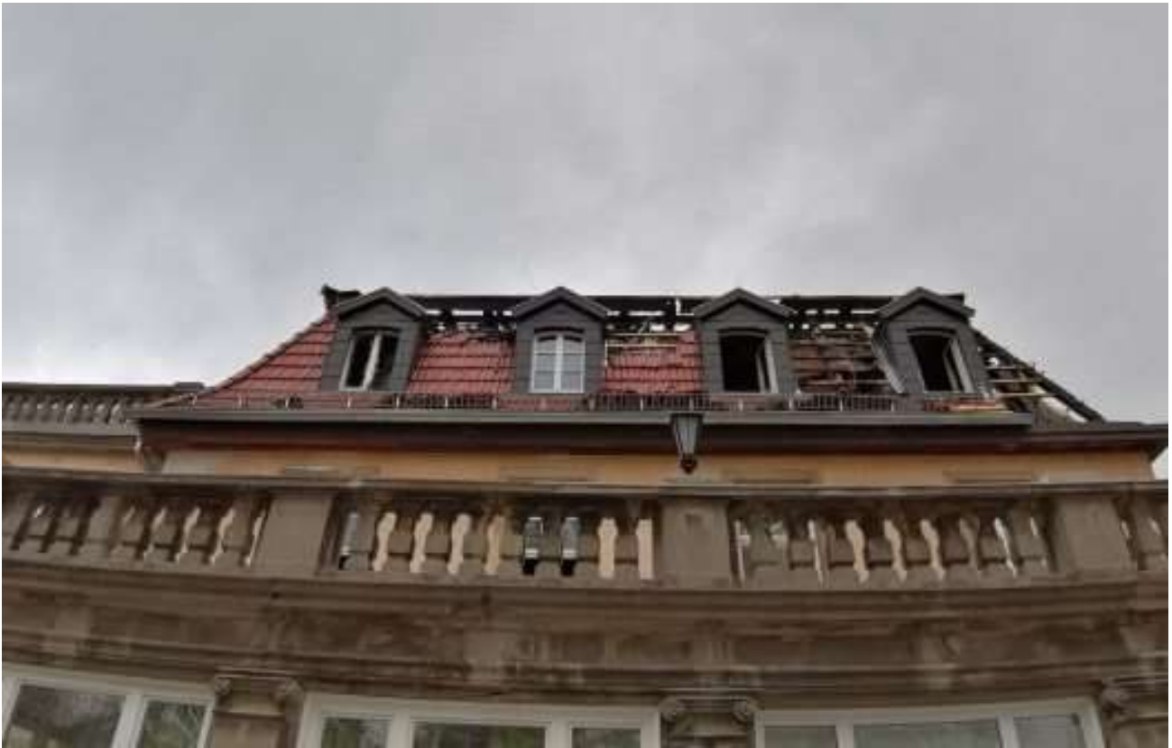
Dunkle Wolken über dem ausgebrannten Dach. Foto: Sophia Fuchs
