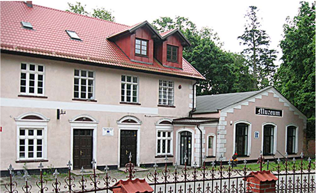
Das jetzige Museumsgebäude in einer Aufnahme von 2009.
