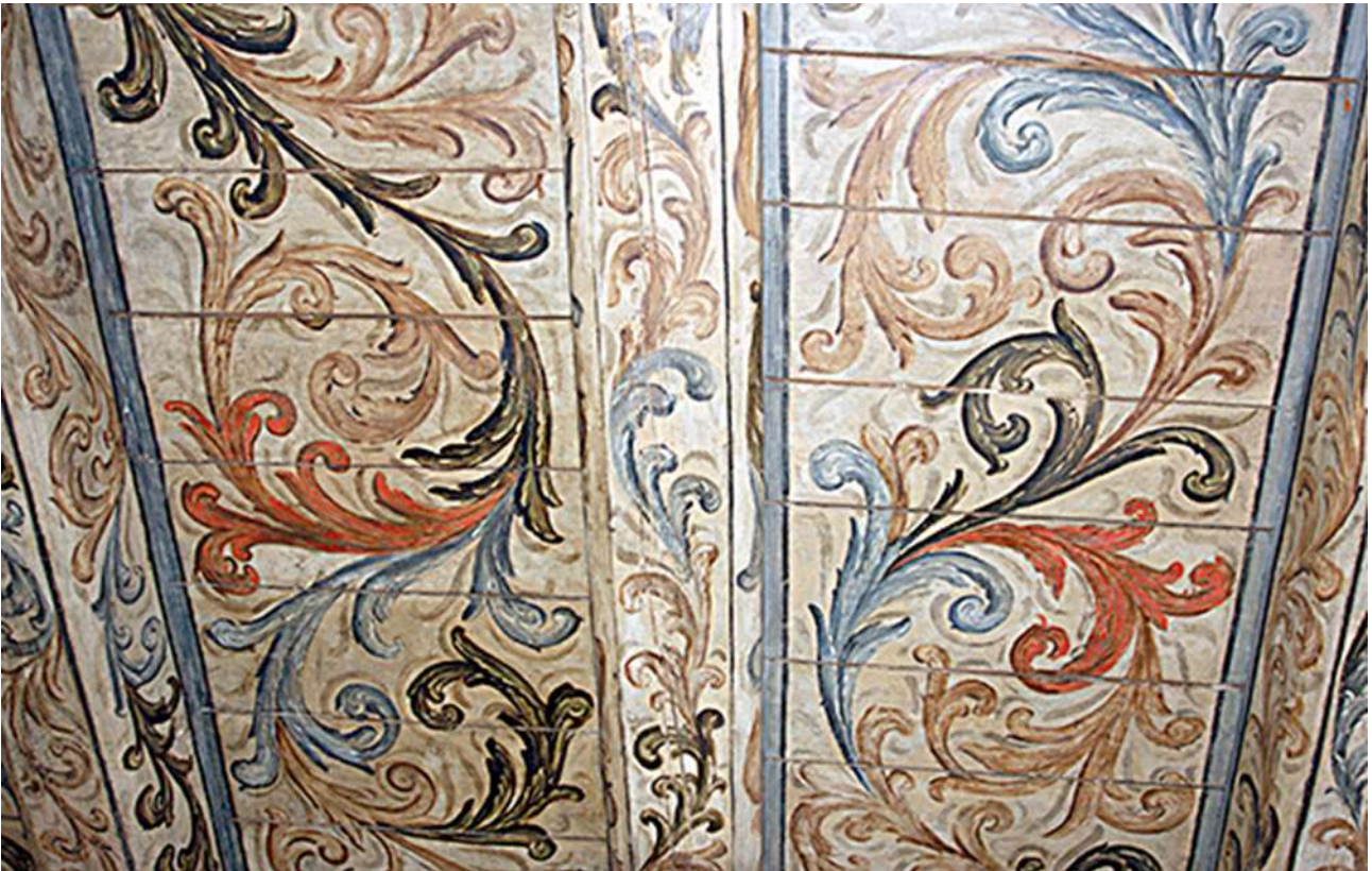
Diese herrliche bemalte Barockholzdecke aus dem Ende des 17. Jh. im Frühstücksraum wurde unter Putzverschalung bei Restaurierungsarbeiten im Schloß etwa um 1993 entdeckt. Aufnahme 2010
